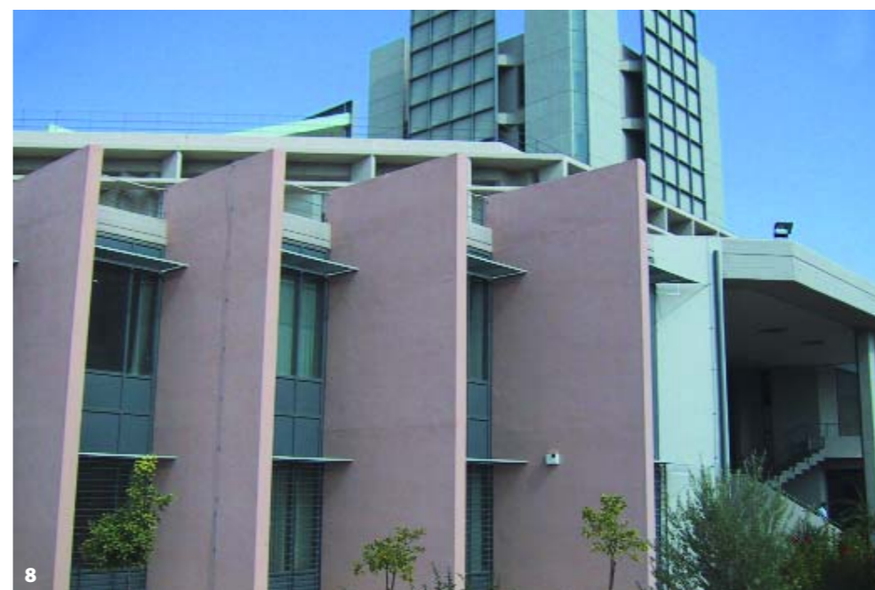
Εικ.8,9: Βιβλιοθήκη του Ε.Μ.Π. στο Ζωγράφου, σχεδιασμένη πάνω σε υπάρχον κτίριο, από τους Αντώνη και Μπούκη Νουκάκη - Μπαμπάλου. Κατακόρυφα στοιχεία τοίχου που διατρέχουν όλο το ύψος αυτού του τμήματος του κτιρίου, λειτουργούν ως κάθετες περιίδες και συνδυάζονται με μεταλλικά οριζόντια στέγαστρα.
