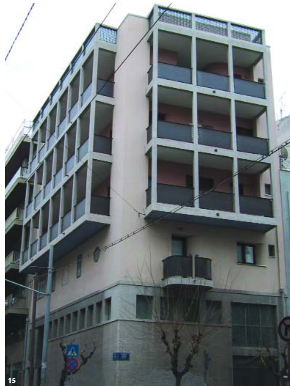
Εικ.15,16: Κατοικία και εργαστήριο - εκθεσιακός χώρος του Αλέκου Φασιανού, σχεδιασμένο από τον Κυριάκο Κρόκο. Έγινε επέμβαση σε τυπική πολυκατοικία του '60. Οι συνηθισμένοι εξώστες κρατήθηκαν στη νέα πρόταση και τροποποιήθηκαν μορφολογικά. Λειτουργούν ως οριζόντια σκιάστρα - στέγαστρα και αποτελούν κυρίαρχο μορφολογικό χαρακτηριστικό της όψης.
