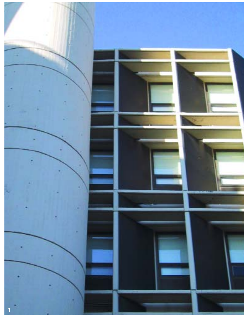
Εικ.1,2,3: Κτίριο γραφείων της Texaco στη Λ. Κηφισίας, σχεδιασμένο από το Γραφείο Παπαγιάννη. Οι κατακόρυφες περσίδες από μπετόν είναι στραμμένες προς τον άξονα Β-Ν στις τρεις όψεις. Στη βορειοδυτική και βορειανατολική όψη, τα ανοίγματα έχουν στραφεί στο βορρά. Στη νότια όψη, υπάρχουν επιπλέον οριζόντια μπετονένια στοιχεία για προστασία από τον μεσημβρινό ήλιο.
