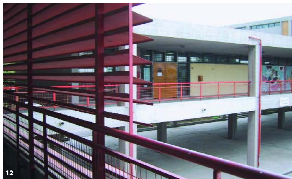
42 Εικ.12: Λύκειο Ηλιούπολης, σχεδιασμένο από τους Τάσο και Δημήτρη Μπέρη. Μεταλλικές σταθερές περισίδες τονισμένες με κόκκινο χρώμα στις όψεις του κτιρίου προστατεύουν ημιυπαίθριους και εσωτερικούς χώρους από την έντονη ακτινοβολία.
